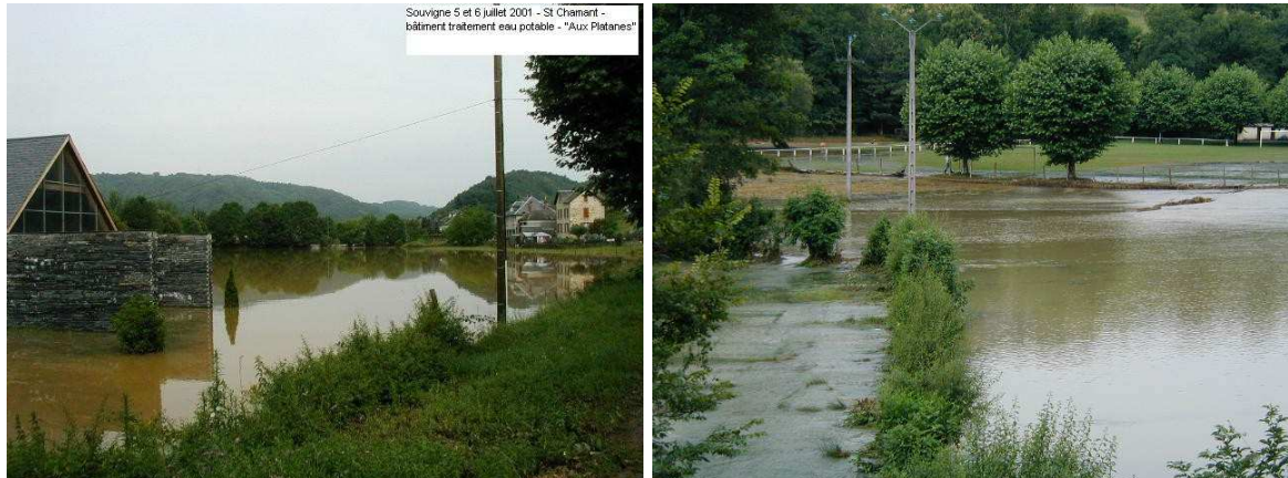
Fig. 14. Station de pompage de Saint Chamant (à gauche), le stade et le camping de Forgès (à droite)
